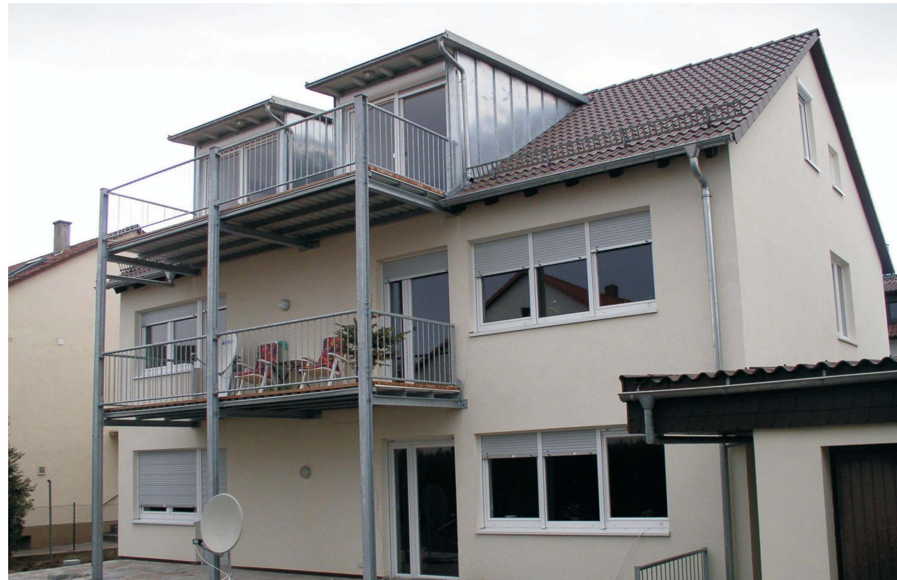
Ansicht Gartenseite mit neuer wärmebrückenfreier Balkonanlage
